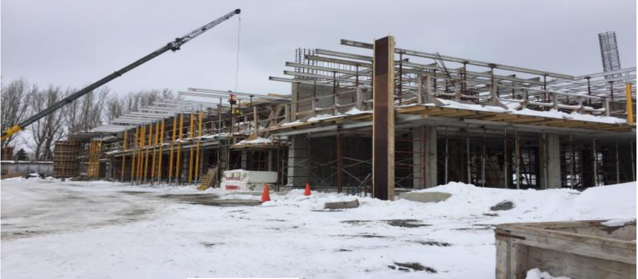
Image du chantier du projet « Habit'Action »
